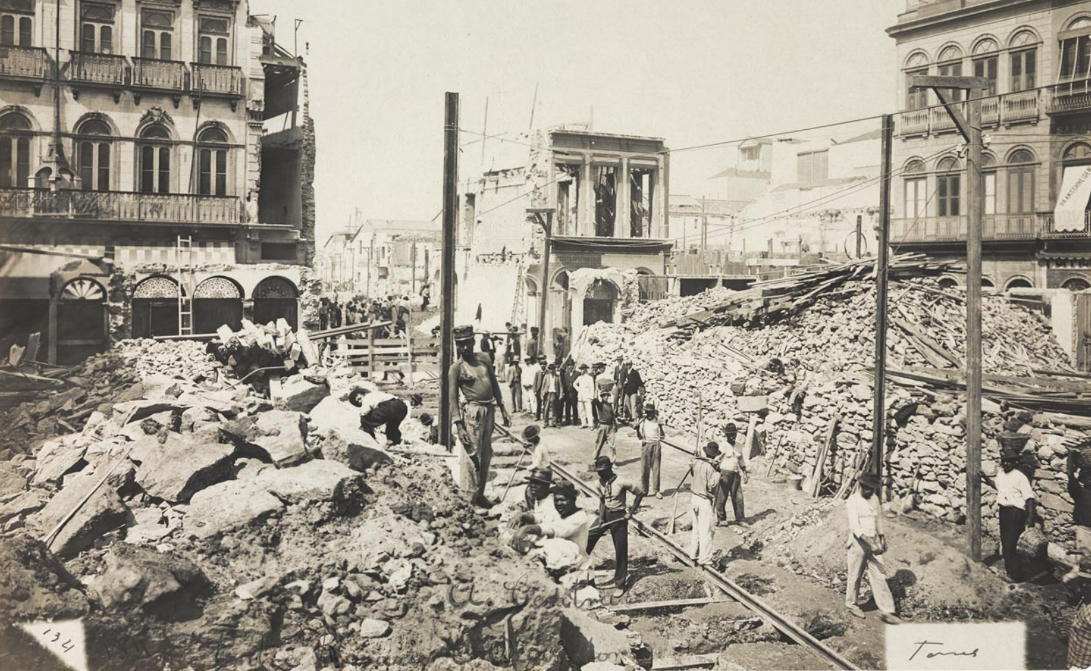
Demolições entre as ruas do Rosário e Ouvidor, avenida Central, atual avenida Rio Branco, Rio de Janeiro, 1904. Crédito: João Martins Torres / Acervo Instituto Moreira Salles
